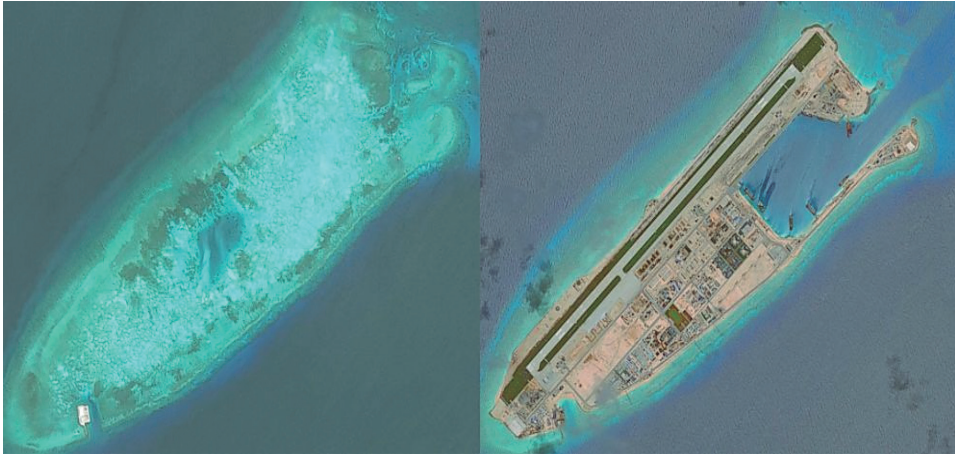
Figura N°3: Arrecife de Fiery Cross, en las islas Spratly, antes y después de las obras militares realizadas por China a partir de 2014.
